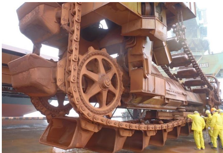
港湾設備 (大形コンベヤチェーン)
