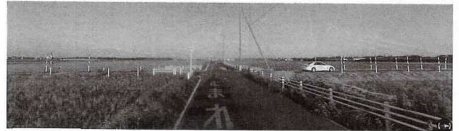
写真3-1 非優先側道路：一時停止標識と路面標示
