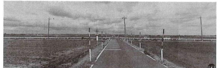
写真3-2 優先道路側：ポールを一定間隔で設置
