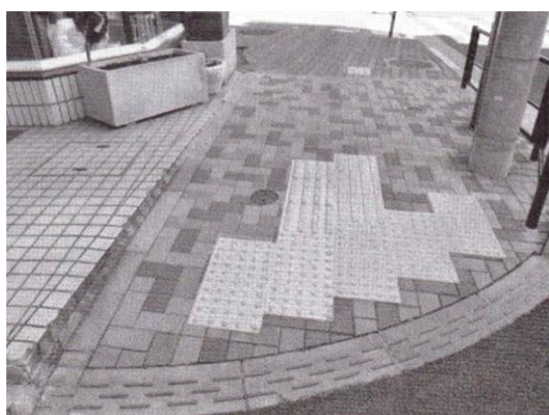
写真 5-1 交差点付近にある点字ブロックや横断歩道と歩道との段差
