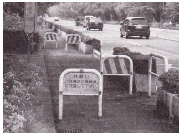
写真 2-2 自転車専用道路のバス停留所前で一時停止させるためのポール
