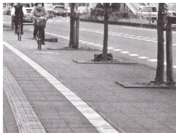
写真 5-2 道路面にある植栽を囲むブロック
