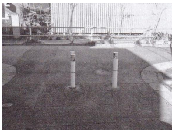
写真 2-1 交差点周辺の自動車進入を防止するためのポール
