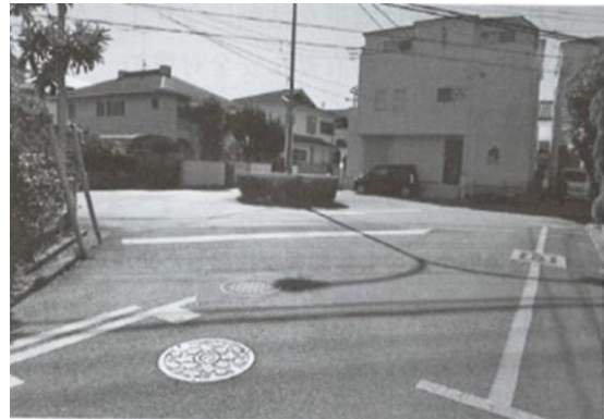
図6 ずれた交差点中央に植え込みを設置して、徐行推進と通行路の逆転を防止している。
